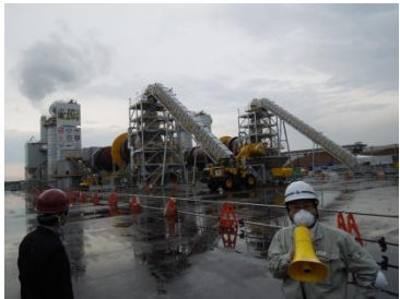
動き始めた仮設の焼却炉
