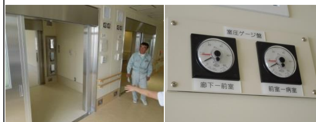
新たに整備された感染症の病棟。病室と廊下の間は二重扉で、室圧を管理することで病室の空気が外に漏れない。
